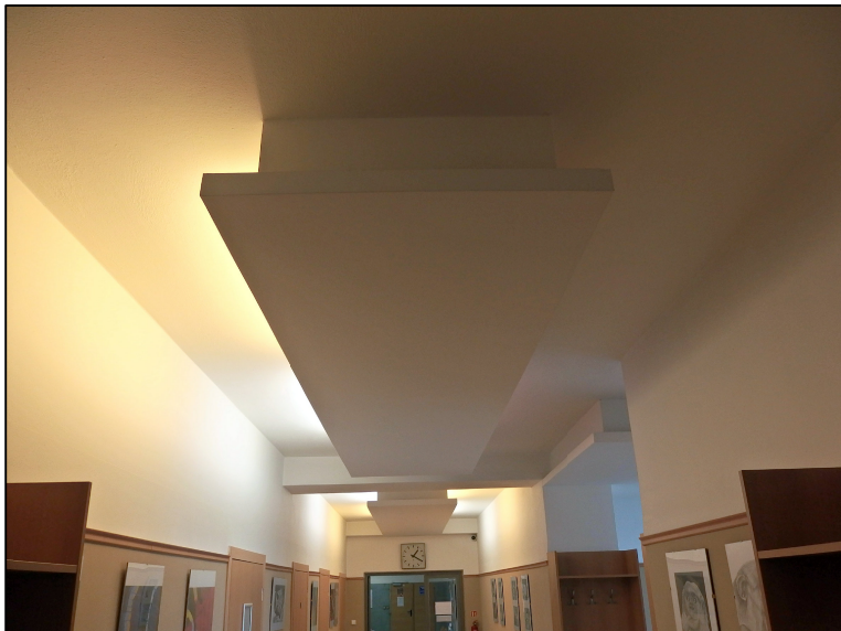
Obr. č.5 Sádrokartonový podhled m.č. A 6.17 - chodba
