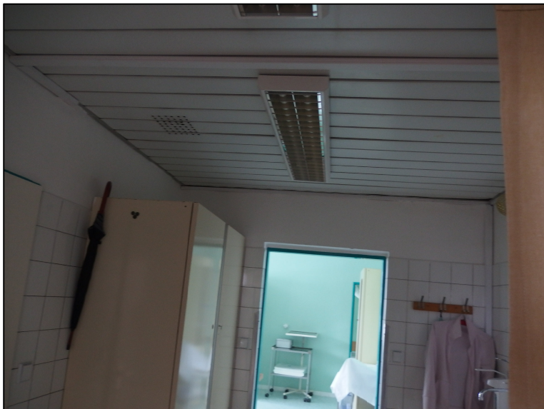
Obr. č.7 Lamelový podhled m.č. A 3.50
