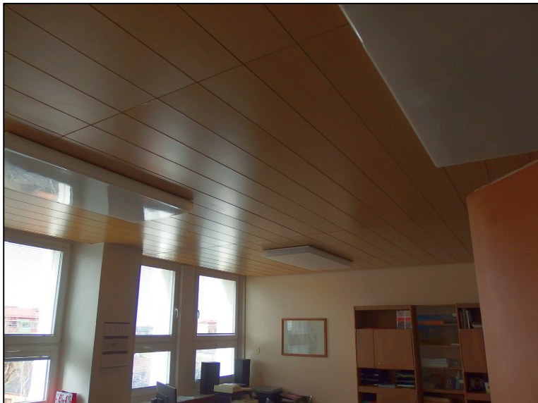
Obr. č.1 Lamelový podhled m.č. A 5.43 - sekretariát polikliniky
